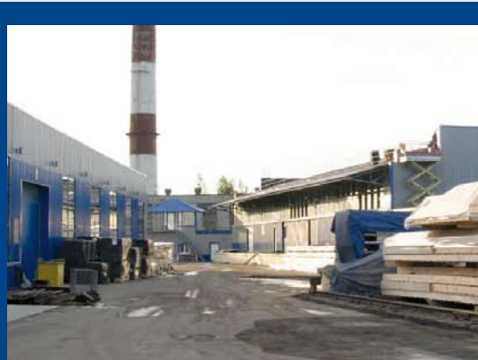
Fertighausproduktion mit Maschinen von WEINMANN im Werk bei St. Petersburg
